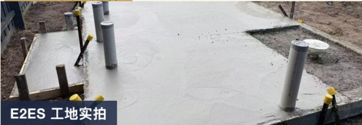
E2ES 工地实拍
